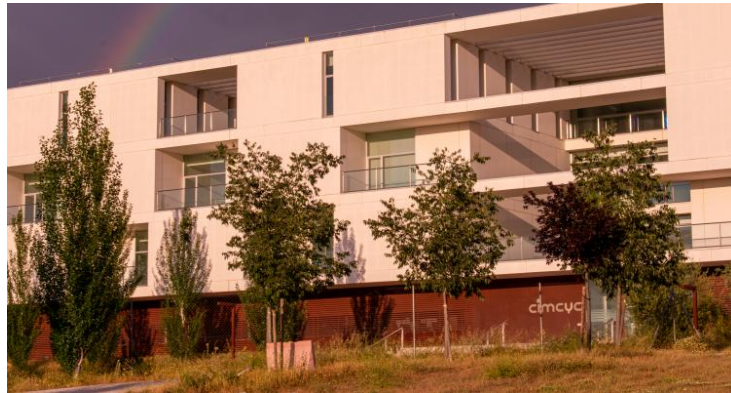
Fachada del centro
