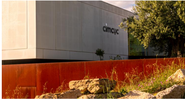
Fachada del centro
