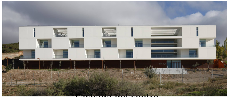
Fachada del centro
