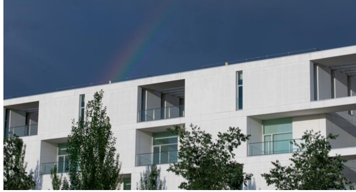
Fachada del centro
